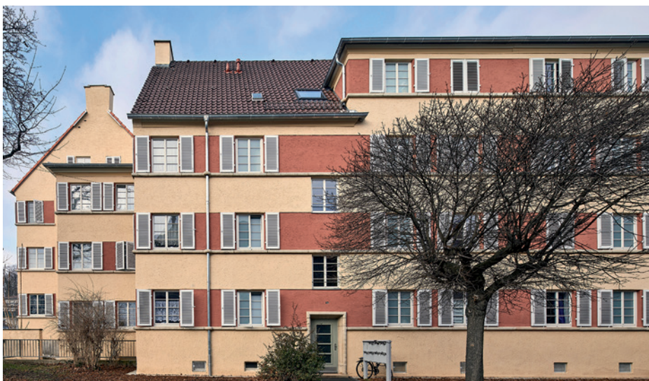
Denkmalgerecht saniert. © Friedemann Rieker
