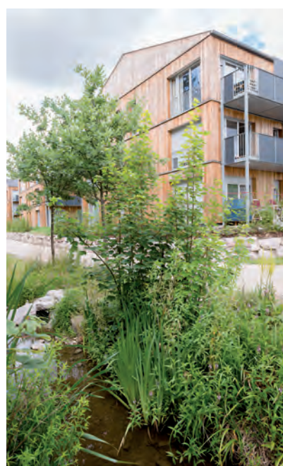
Offenlegung des Flußlaufs
