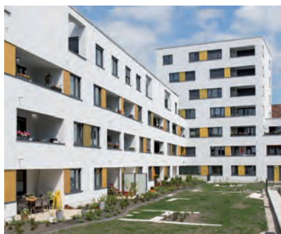
Hofseite: Grüne Terrasse auf Tiefgaragendecke
