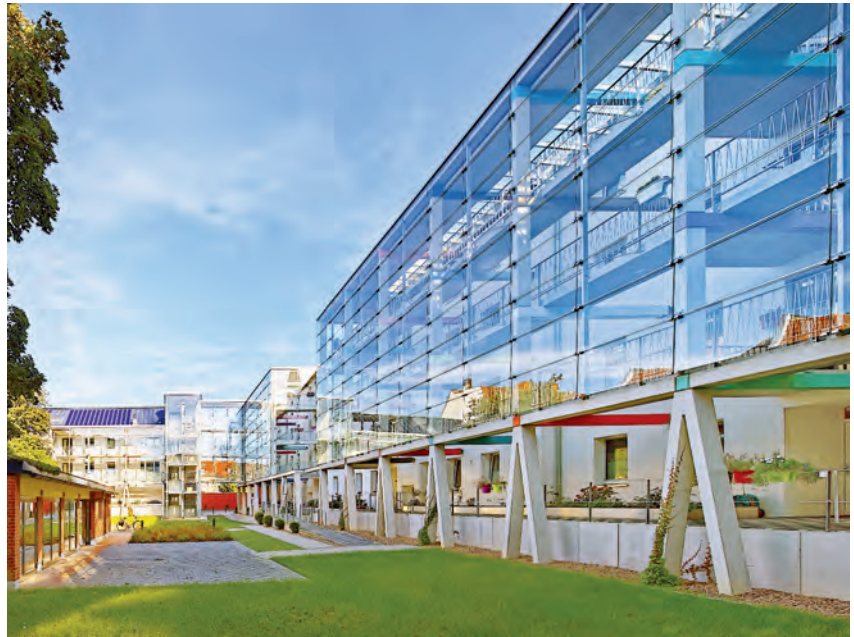
nach der Sanierung: Begrünter Innenhof mit Gemeinschaftshaus
