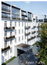
Aufstockung in Modulbauweise
