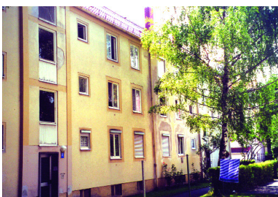
Quartiersinnenbereich vor ... und nach der Modernisierung (rechts)
