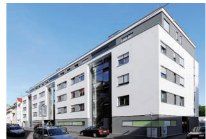
Fünf Stockwerke hat das lichtdurchflutete Gebäude mit modernsten Ansprüchen an den Klimaschutz in Citylage
