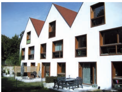
Die Freifläche im Süden gliedert sich in Mietgärten und in einen allen Bewohnern zugänglichen Garten
