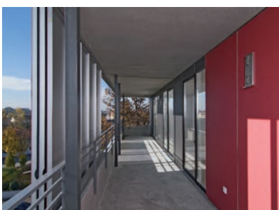
Hohe Wirtschaftlichkeit der Konstruktion durch den Einsatz von Betonfertigteilen an den Laubengängen
