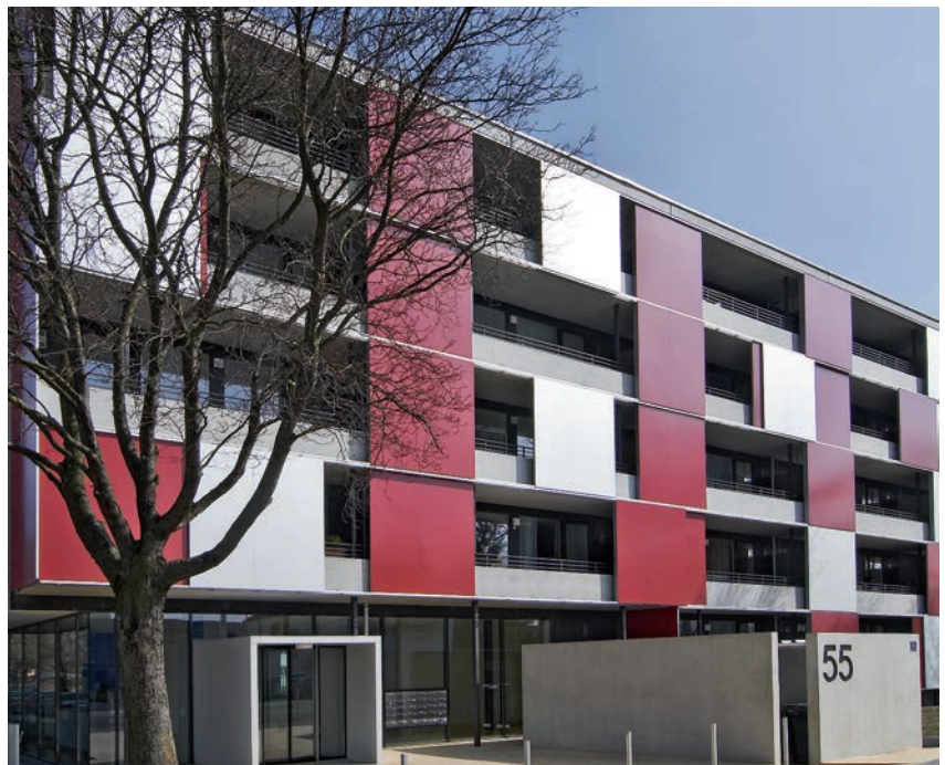
Das Erscheinungsbild zur Straße ist geprägt durch große Alu-Scheiben, Sicht- und Sonnenschutz bieten und durch das Wechselspiel der Ladenstellungen von Wohnung zu Wohnung ein sehr lebendiges Bild ergeben
