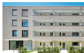
Mineralischer Putz der Fassaden (keine Algen = keine Pestizide)
