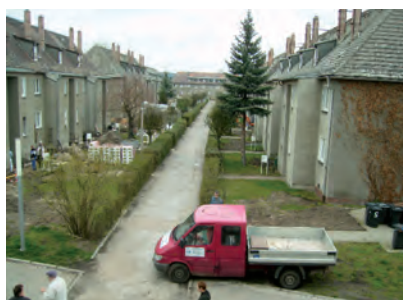
Vor der Sanierung: Aufwertung einer unattraktiven und von Leerstand geprägten Siedlung
