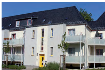
Fast alle Wohnungen erhielten einen Balkon: Hier neue Eckbalkonnlösungen
