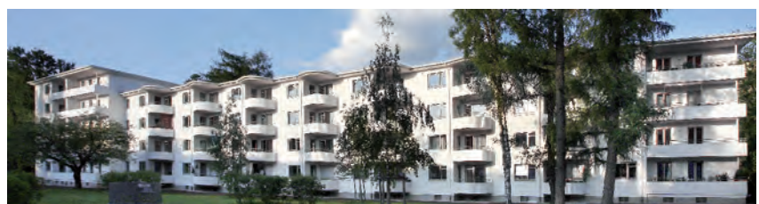
Trotz Wärmedämmverbundsystem und Einbau neuer Fenster blieb die ursprüngliche Gestaltung des Architekten Freymuth erhalten
