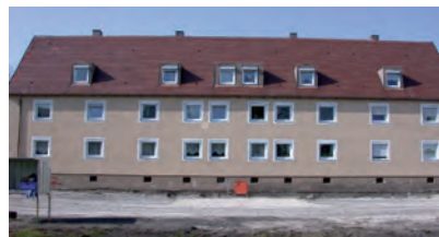
Bestandsgebäude aus den 1950er Jahren
