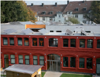
Ziegelbau: Nach dem Umbau befinden sich hier barrierefreie Wohnungen
