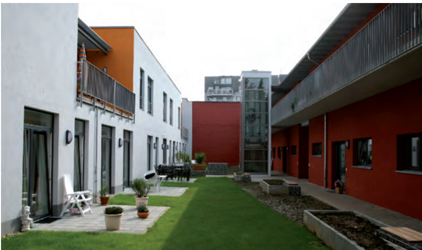
Neuer Wohnhof: Die barrierefreie Erreichbarkeit der Wohnungen wird über Laubengänge und Aufzugsturm gesichert
