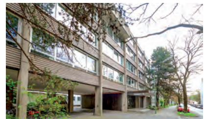
Neue hochwärmegedämmte Brüstungselemente und Fenster im EnEV-Standard
