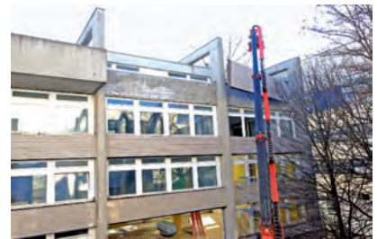
Abbruch der Betonfertigteilebrüstungen
