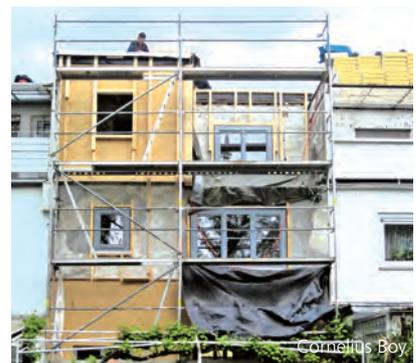
Sanierung der Fassade: Holzständerkonstruktion mit Holzfaserdämmstoffen
