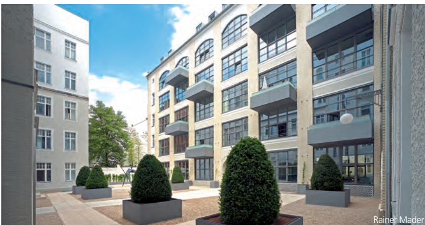
Umbau des Fabrikgebäudes: Hohe Qualität in Gestaltung und Ausführung
