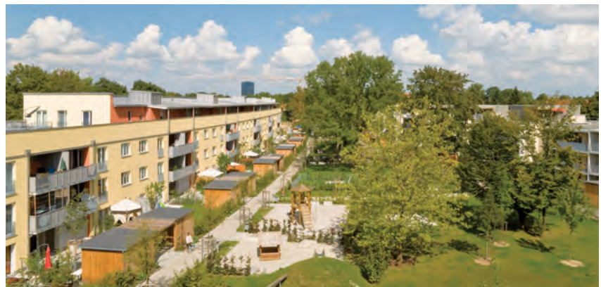
Das oberste Geschoss ist hofseitig um die Breite eines Laubenganges zurückgesetzt. Über diesen erreichen die Mieter zusätzliche Abstellräume.
