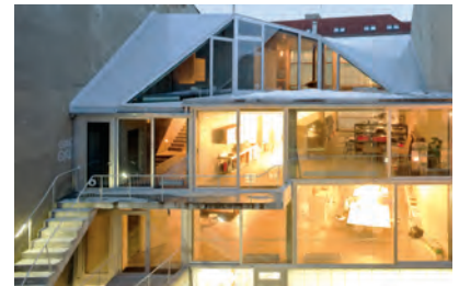
Das Gebäude ist nutzungs- und aneignungsoffen geplant. Die auf Winkeln ruhende Fassade ist einfach austauschbar, so dass sie jederzeit an die Bedürfnisse der dahinter liegenden Nutzungen angepasst werden kann.
