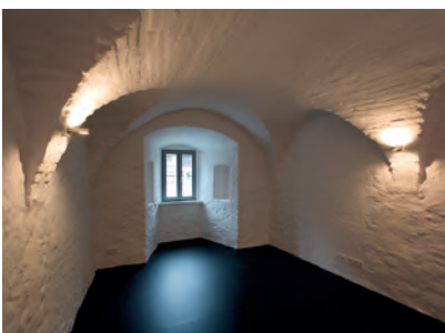
In die historischen und neuen Wände wurden Temperierleitungen zur Grundbeheizung eingebaut.
