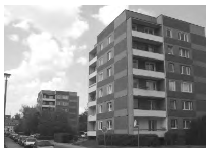
Bestandsgebäude vor der Sanierung
