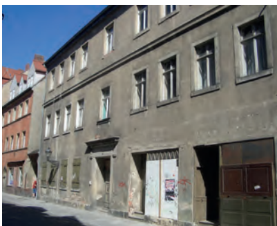
Umnutzung einer Bauruine zu einem internationalen Bildungsstandort
