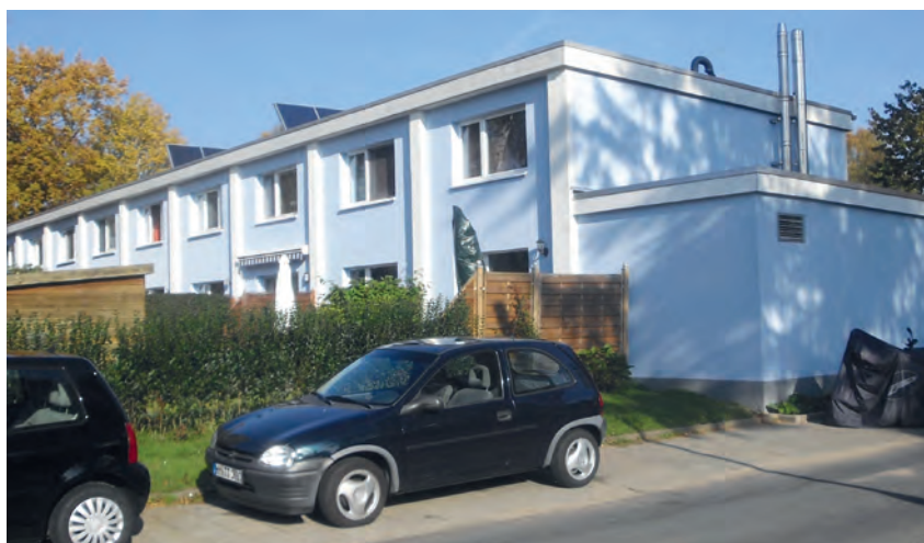
Ca. 15 Prozent der benötigten Wärme pro Jahr werden von den Solaranlagen geliefert, den Rest liefert die Heizzentrale.
