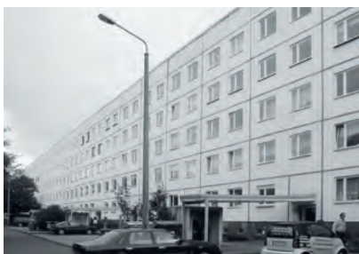
Straßenansicht vor der Modernisierung
