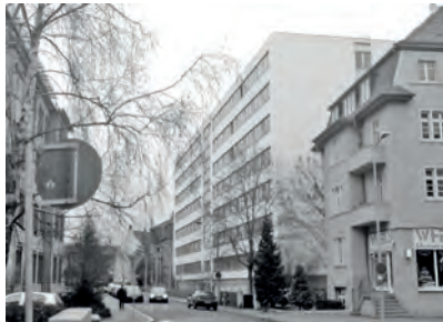
Skelettbau aus den 1970er Jahren
