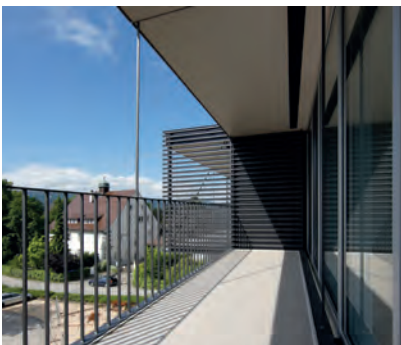
Im Bereich der Fensterelemente setzt sich der Fassadenrost in Form beweglicher Fensterläden fort.
