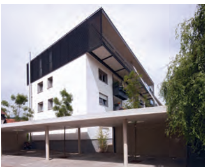
Im begrünten Carportdach ermöglichen runde Aussparungen die Pflanzung von drei großen Straßenbäumen.
