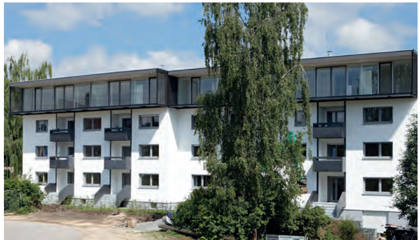
Die Dachaufstockung wurde mit einem Flachdach und einer großflächigen Photovoltaikanlage ausgeführt. Die Balkone wurden vergrößert und im Erdgeschoss an den Garten angebunden.
