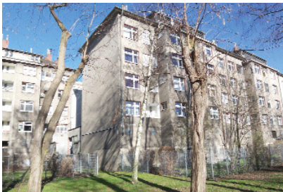
Bestand vor der Sanierung
