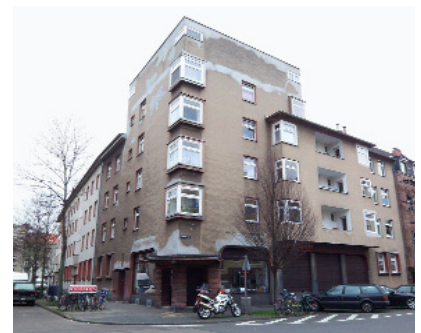
2006: stark sanierungsbedürftig; Beginn der tiefgreifenden Erneuerung
