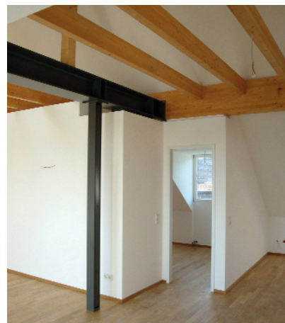
Die bisher als Trockenräume genutzten Dachgeschosse werden ausgebaut.
