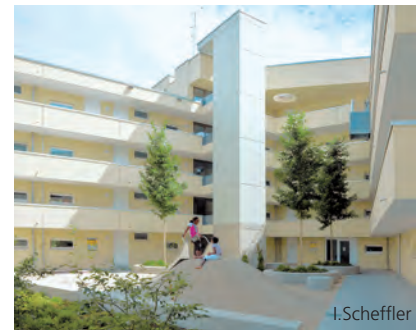
Innenhof mit zentralem Aufzugsturm
