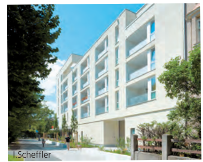
Fassade Thalkirchner Straße
