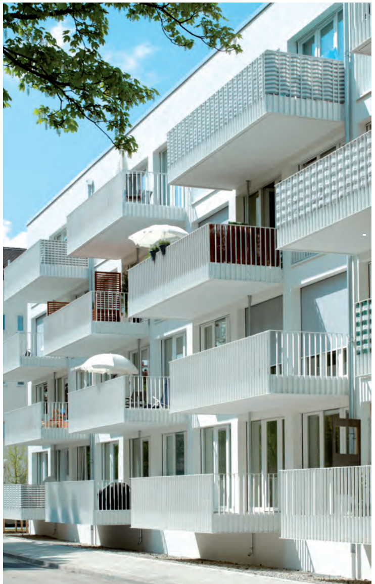
Hohe Wohnqualität: Großzügige Balkone ermöglichen eine gleichmäßige Besonnung über die Geschosse
