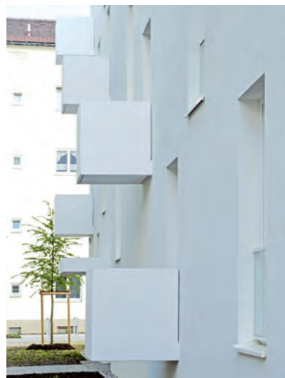
Versetzt angeordnete Lochfenster mit kleinen Austrittsbalkonen
