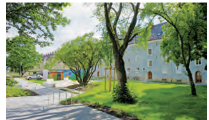
Umfangreiche Wohnumfeldverbesserungen: Rampen schaffen Barrierefreiheit
