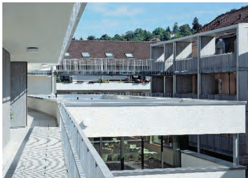
Laubengängen und Stege verbinden den Neubau mit dem Bestandsgebäude
