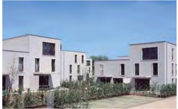
Ostfildern, Max-Ackermann-Weg, Willi-Baumeister-Weg Scharnhäuser Park Bauherr: HKPE, Hofkammer Projektentwicklung Ostfildern Architekt: Fink + Jocher, München
