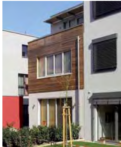
Bauherr/ Eigentümer Silke Roth-Braunbarth und Markus Braunbarth, Saarbrücken Entwurf/ Planung Markus Ott, Architekt AKS BDA, OAI, Saarbrücken Statik WPW-Ingenieure GmbH, Saarbrücken; Baugrund WPW Geoconsult GmbH, Saarbrücken
