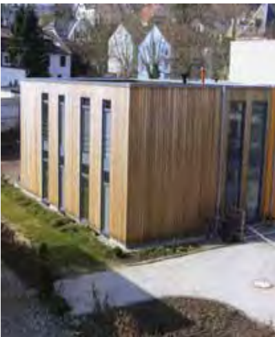
Bauherr/ Eigentümer Birgit Hoffmann und Dieter Bülte, Saarbrücken Entwurf/ Planung Dipl.-Ing., Architekt Gereon Hessel, Saarbrücken Energie EUA Pertz Ingenieurbüro, Saarbrücken Baugrund WPW Geoconsult, Saarbrücken
