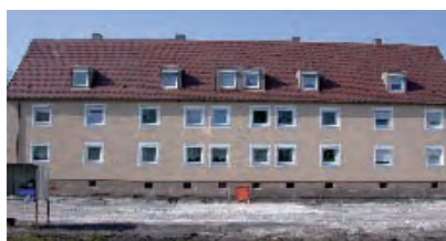
Bestandsgebäude aus den 1950er Jahren
