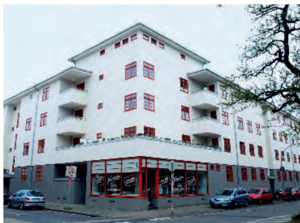
Wohnanlage Blauer Hof
