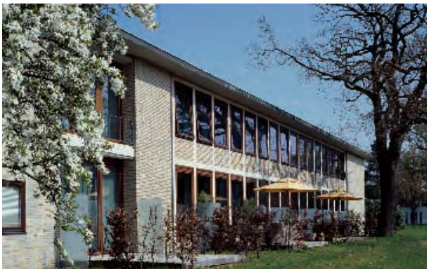
Hamburg, Parkstraße, Reemtsma Park Umnutzung Verwaltungsgebäude 1950er Jahre zu Wohnungen Bauherr: GbR Reemtsma Park-Gator mbH, Hamburg Architekt: Helmut Riemann Architekten GmbH, Lübeck
