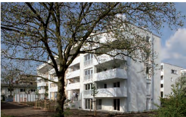
Darmstadt, Wohnanlage Holzhofallee / Scheppallee Modernisierung und Umbau Wohnsubstanz 1950er Jahre Bauherr: Bauverein AG, Darmstadt Architekt: Architekten Hirschmüller Schmidt, Darmstadt
