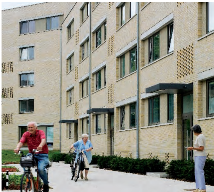
Die Hauseingänge im Altbau Süd wurden alle erneuert, im Hintergrund der Neubau
