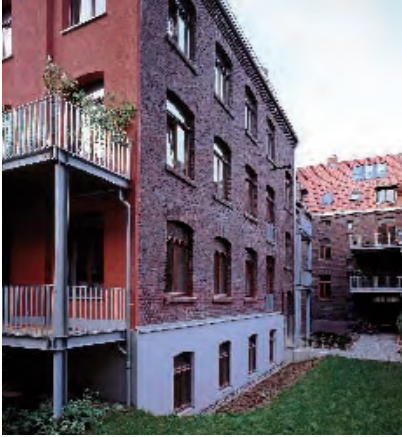
Köln, Franziskastraße Sanierung und Umbau Baudenkmal Bauherr: Eigentümergemeinschaft Franziskastraße, Münster Architekt: Boris Enning, BDA Stadtplaner, Köln
