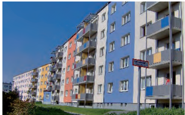
Oschatz, Servicewohnanlage, Goethestraße Modernisierung und Anbau Wohnsubstanz 1970er Jahre Bauherr: Oschatzer Wohnstätten GmbH Architekt: Dietmar Schmidt, Steffi Spiegel, Oschatz
