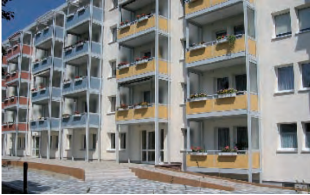
Chemnitz, Wohn-Park Geibelhöhe, Albert-Jentzsch-Straße Modernisierung Wohnbausubstanz 1950er Jahre Bauherr: Chemnitzer Allgemeine Wohnungsbaugenossenschaft e.G. Architekt: C & E Consulting und Engineering GmbH, Chemnitz
