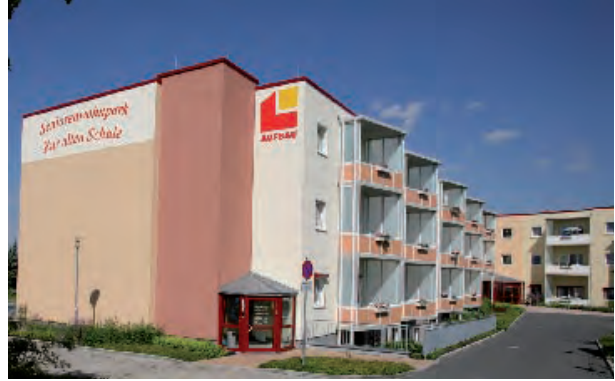
Gera, Seniorenwohnpark "Zur alten Schule", Grüner Weg Umbau einer Förderschule Bauherr: Wohnungsbaugenossenschaft "Aufbau" Gera e.G. Architekt: Heike Wolfram, Gera
