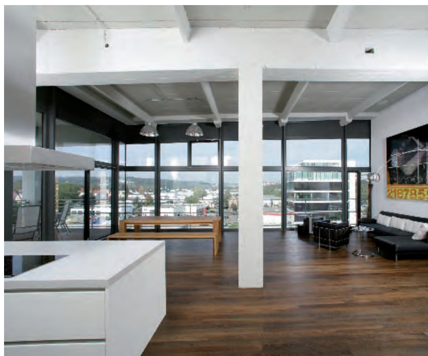
Durch das gleichmäßige Raster konnten Grundrisse je nach Bedarf flexibel in Form, Größe und Gestalt vom Apartment bis hin zum Loft gewählt werden
