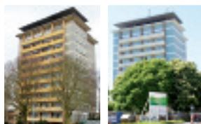
Die Strömungsplatte (zweites Dach) hat heute keine Funktion mehr - wurde aus Denkmalschutzgründen jedoch saniert.
