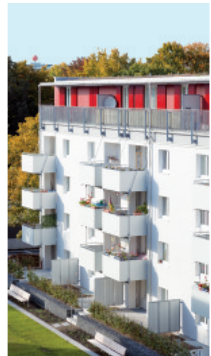
Aufstockung der Bestandsgebäude in Holzbauweise
