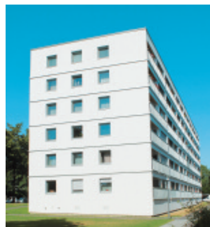
Das Projekt ist ein Demonstrationsvorhaben des EU Forschungsprojektes „E2ReBuild“.
