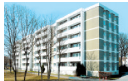
Bestand vor der Sanierung
