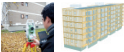
Planung: Tachymetrisches Aufmaß; Modell der Holzfassade (TES-Energy Facade)
