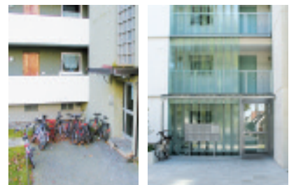
Die Eingangsbereiche wurden neu gestaltet (links vor der Modernisierung)
