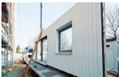
Transport der Holzfassadenelemente
