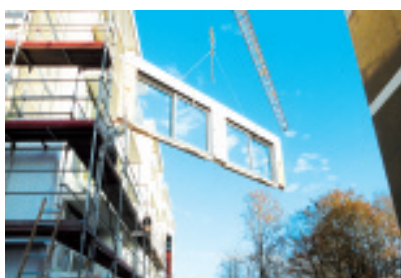
Montage des vorgefertigten Bausystems
