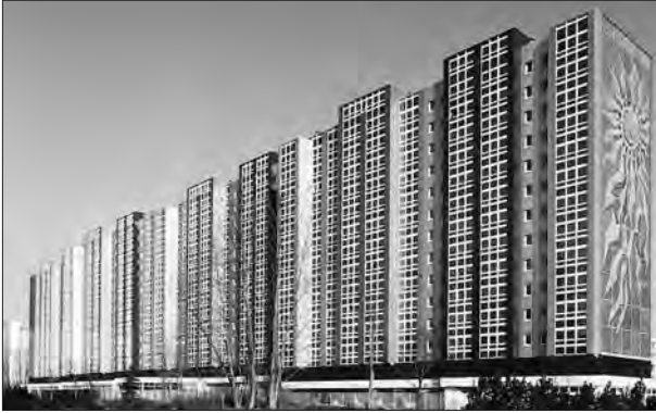
Rostock Hochhausumbau Wohnanlage „Rasmus“ Bauherr: WIRO, Wohnungsgesellschaft Rostock mbH Architekt: F. L. Carewicz, Rostock
