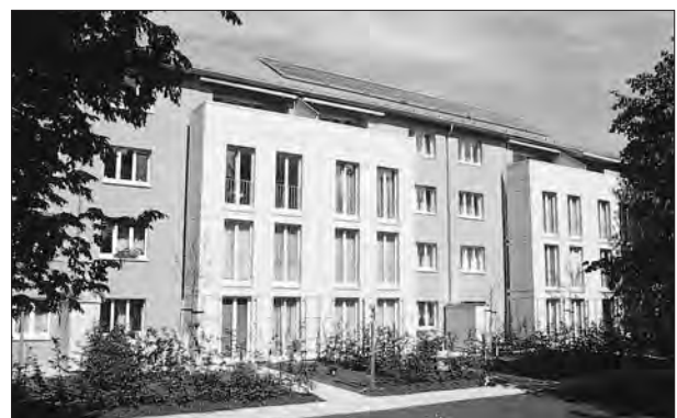
Regensburg, Humboldtstraße 8,10,12 Ökologische Modernisierung Bauherr: Stadtbau GmbH, Regensburg Architekt: Stadtbau GmbH; Nickelkoppe, M. Bach, H. Teufl, D. Strebl, Regensburg
