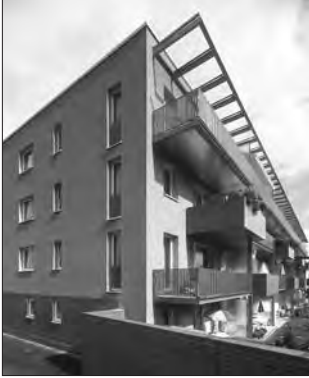
Leinefelde, Büchnerstraße 18-24 Rückbau und Komplettsanierung, Wohnumfeldgestaltung Bauherr: Leinefelder Wohnungsbaugenossenschaft Architekt: Stefan Forster Architekten, Frankfurt/Main
