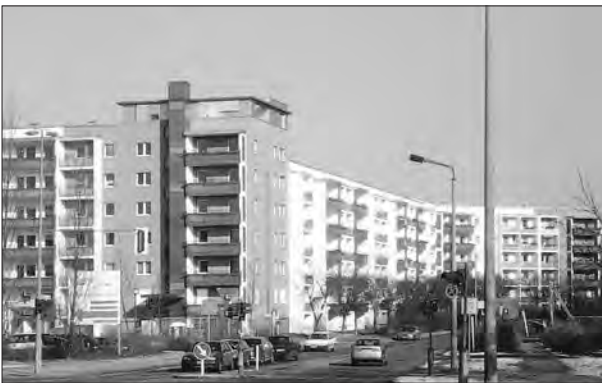
Berlin-Hellersdorf, Rotes Viertel Komplettsanierung eines Wohnquartiers Bauherr: Stadt und Land, WoGeHe, Berlin Architekt: CASA NOVA ARCHITEKTEN, Berlin
