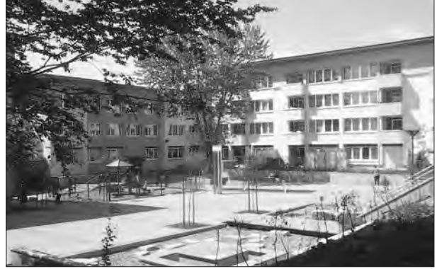
Forchheim, Pestalozzistraße Modernisierung einer Mietwohnanlage Bauherr: Joseph-Stiftung, Bamberg Architekt: Architekturbüro Bahl & Bahl, Forchheim
