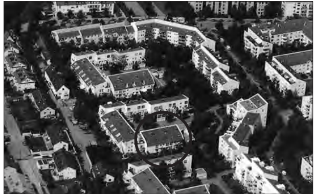
München Umbau und Umgestaltung eines Einfamilienhauses Bauherr: Jochen Nägele und Irmengard Berner, München Architekt: Archilab Architekturbüro, München
