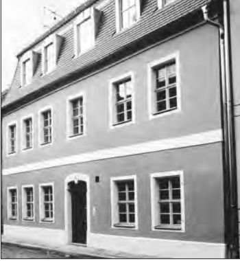
Finsterwalde, Große Ringstraße 4 Denkmalpflegerische Modernisierung Bauherr: Wohnungsgesellschaft Finsterwalde mbH Architekt: Architektur- und Planungsbüro Schweizer, Berlin
