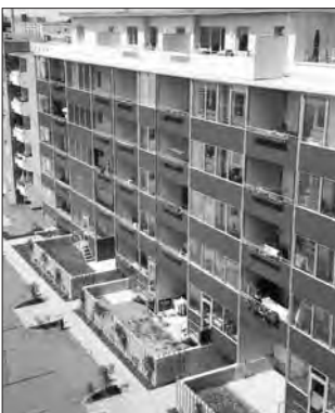
Stralsund, Lion-Feuchtwanger-Straße 52-58 Umbau und Modernisierung eines Wohnblocks Bauherr: Wohnungsbaugenossenschaft „Aufbau“ e.G., Stralsund Architekt: Architekturbüro Vicent, Berlin
