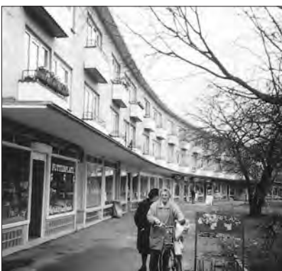
Hamburg, Mahlhaus 1-1f Komplettsanierung Bauherr: Mietergenossenschaft Gartenstadt Farmsen e.G, Hamburg Architekt: Uwe Jentz
