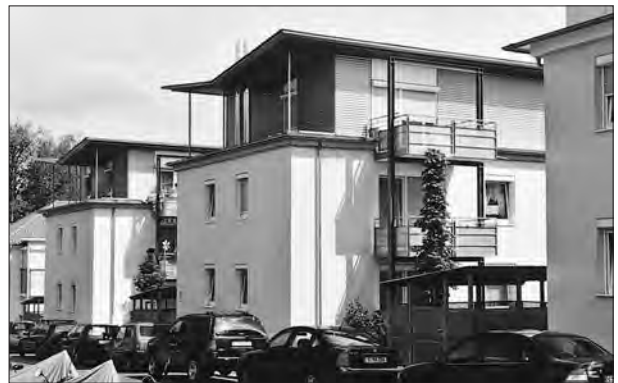
Stuttgart, Sparrhärmlinweg 67+69 Generalsanierung und Dachgeschossaufstockung Bauherr: Stuttgarter Wohnungs- und Städtebaugesellschaft mbH Architekt: Architekturbüro Herkommer, Stuttgart
