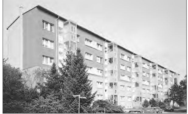
Markkleeberg, Zwenkauer Str. 1-11 Quartiersanierung Bauherr: Wohnungsbaugesellschaft Markkleeberg mbH Architekt: Ronald Wanderer, Markkleeberg
