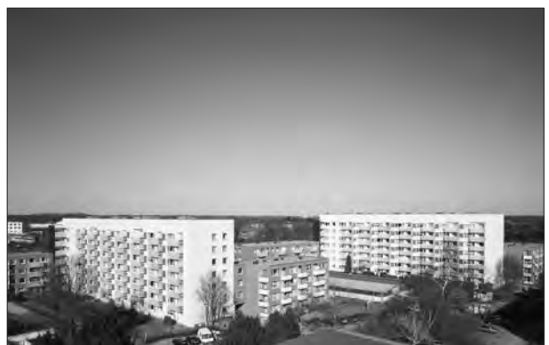
Hamburg, Lentersweg 25-73 Fassadensanierung Bauherr: Waldorfer Wohnungsbaugenossenschaft e.G., Hamburg Architekt: Streb + Partner Architekten, Hamburg
