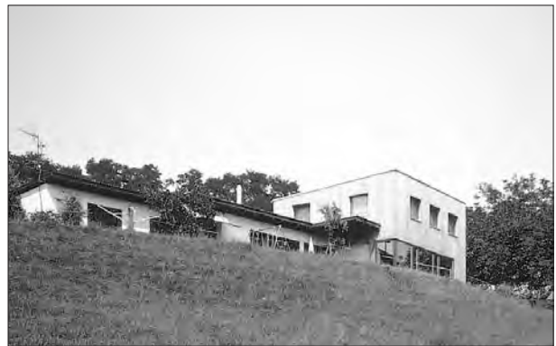
Wachtberg-Niederbachem, Auf dem Langenberg Umbau eines Wohnhauses Bauherr: Ute und Bernhard Luhmer Architekt: heydorn.eaton.architekten, Berlin
