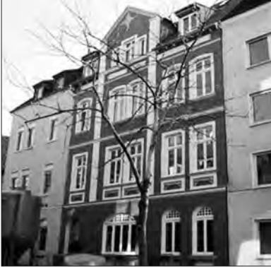
Münster, Margaretenstraße 12 Kernsanierung Mehrfamilienhaus Bauherr: Eigentümergemeinschaft Margaretenstraße 12, Münster Architekt: Planungsbüro Volker Hellige, Münster
