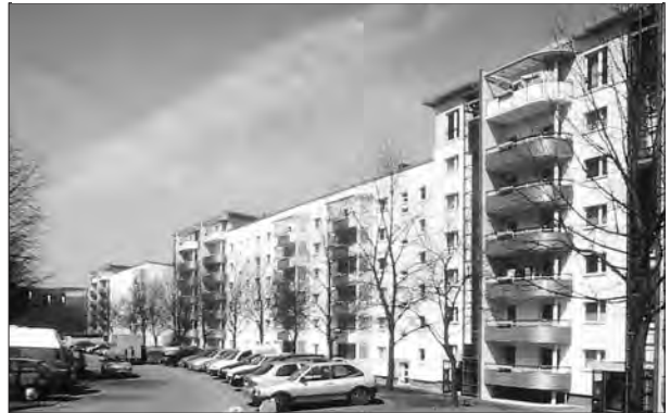
Jena-Winzerla, Ernst-Zielinski-Str./Hugo-Schrade-Str. Rückbau und Umgestaltung von Plattenbauten Bauherr: Wohnungsgenossenschaft „Carl Zeiss“ e.G, Jena Architekt: BBP Bauconsulting mbH, Berlin
