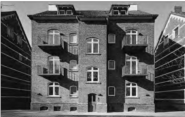
Leverkusen-Opladen, Humboldtstraße 91 Modernisierung eines denkmalgeschützten Wohngebäudes Bauherr: GEWG Wuppertal Architekt: GEWG Wuppertal mit Heike Klankwarth, Wuppertal
