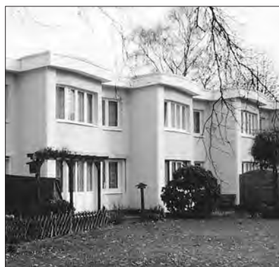
Hamburg, Ortsteinweg Komplettsanierung Bauherr: Mietergenossenschaft Gartenstadt Farmsen e.G, Hamburg Architekt: Uwe Jentz
